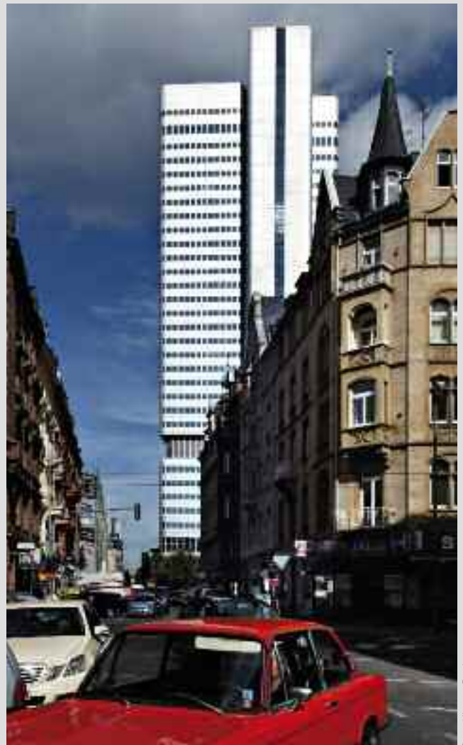
Sanierung und Umbau Silvertower, Frankfurt
