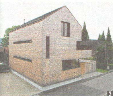
1 Für die Konstruktion, den Innenausbau und die Fassade wurden Massivholz, Stroh, Flachs und Lehm verwendet 2 Wände, Dach und der Boden im Erdgeschoß bestehen aus 43 cm starken strohgedämmten Holzrahmenelementen 3 Die Fassade wurde mit Holzschindeln verkleidet 4 Das Haus prägt das Ortsbild weil es direkt an der Straße mitten im Zentrum von Hard liegt
