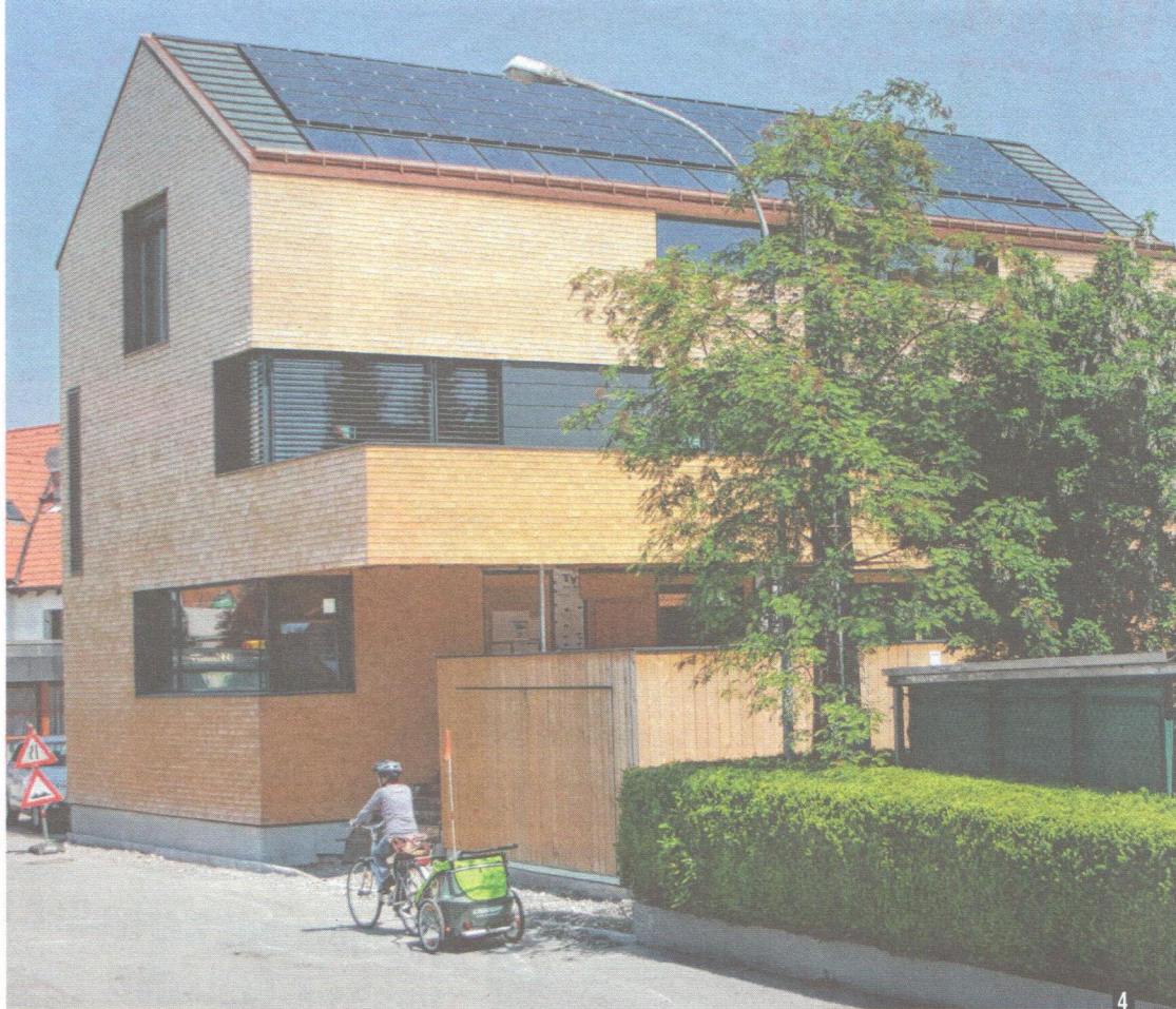
1 Für die Konstruktion, den Innenausbau und die Fassade wurden Massivholz, Stroh, Flachs und Lehm verwendet 2 Wände, Dach und der Boden im Erdgeschoß bestehen aus 43 cm starken strohgedämmten Holzrahmenelementen 3 Die Fassade wurde mit Holzschindeln verkleidet 4 Das Haus prägt das Ortsbild weil es direkt an der Straße mitten im Zentrum von Hard liegt
