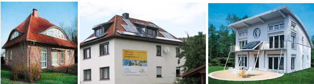
Abbildung 5: links: bei dieser Dachform kann kaum ein Standardmodul montiert werden. Mitte: Gauben und Walmform engen die nutzbare Solarfläche ein. Schattenwurf und unterschiedliche Neigung der Module erfordern zusätzliche MPP-Tracker-Technologien, um Ertragsverluste zu minimieren. rechts: Passivhaus mit Dach nach Nord und reichlicher Verglasung der Südfassade – es verbleibt kaum Potenzial für eine Solar- bzw. Photovoltaikanlage.
