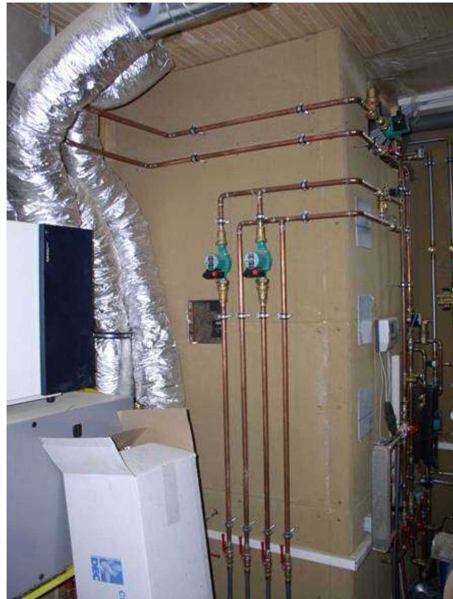
Links: Der zentrale 1500 Liter Solarspeicher vor dem Einbau; Rechts: Der fertig eingebaute, mit Flachs gedämmte und mit n&l Biofaser-Lehmverbundplatten verkleidete Speicher (mit noch unisolierten Leitungen)
