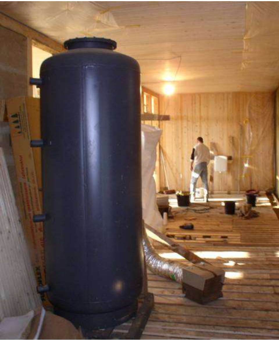
Links: Der zentrale 1500 Liter Solarspeicher vor dem Einbau; Rechts: Der fertig eingebaute, mit Flachs gedämmte und mit n&l Biofaser-Lehmverbundplatten verkleidete Speicher (mit noch unisolierten Leitungen)
