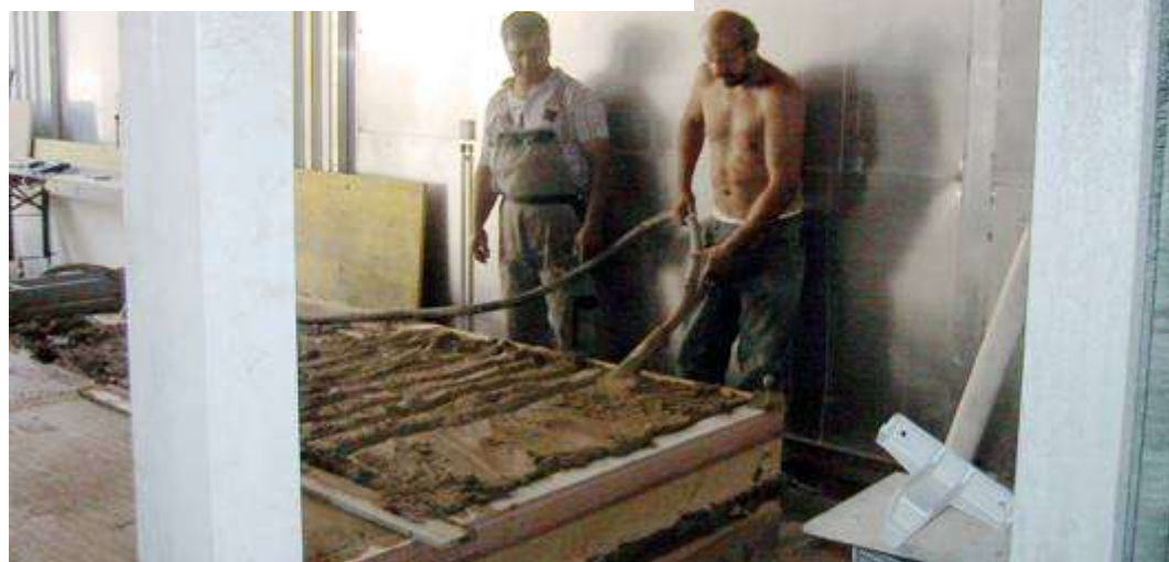
Bild G: Zweilagige Beschichtung der Wandmodule mit Biofaserlehm BFND3 und D2 A. Mikrobletelle statt chemischer Stabilisierung ermöglicht den Einsatz von Lehmbaustoff auch an bewitterten Außenwänden. Im Hintergrund ein bereits fertig beschichtetes Außenwand-Modul.
