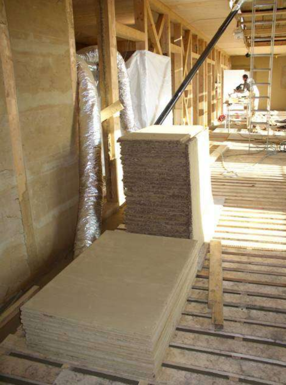
Ganz links: Im Werk vorgefertigte Ausfachung zweier Mittelwand-Felder mit Stampflehm Im Vordergrund: Biofaser-Lehm-Fertigplatten zur rationellen Montage in den ausgekreuzten Gefachen
