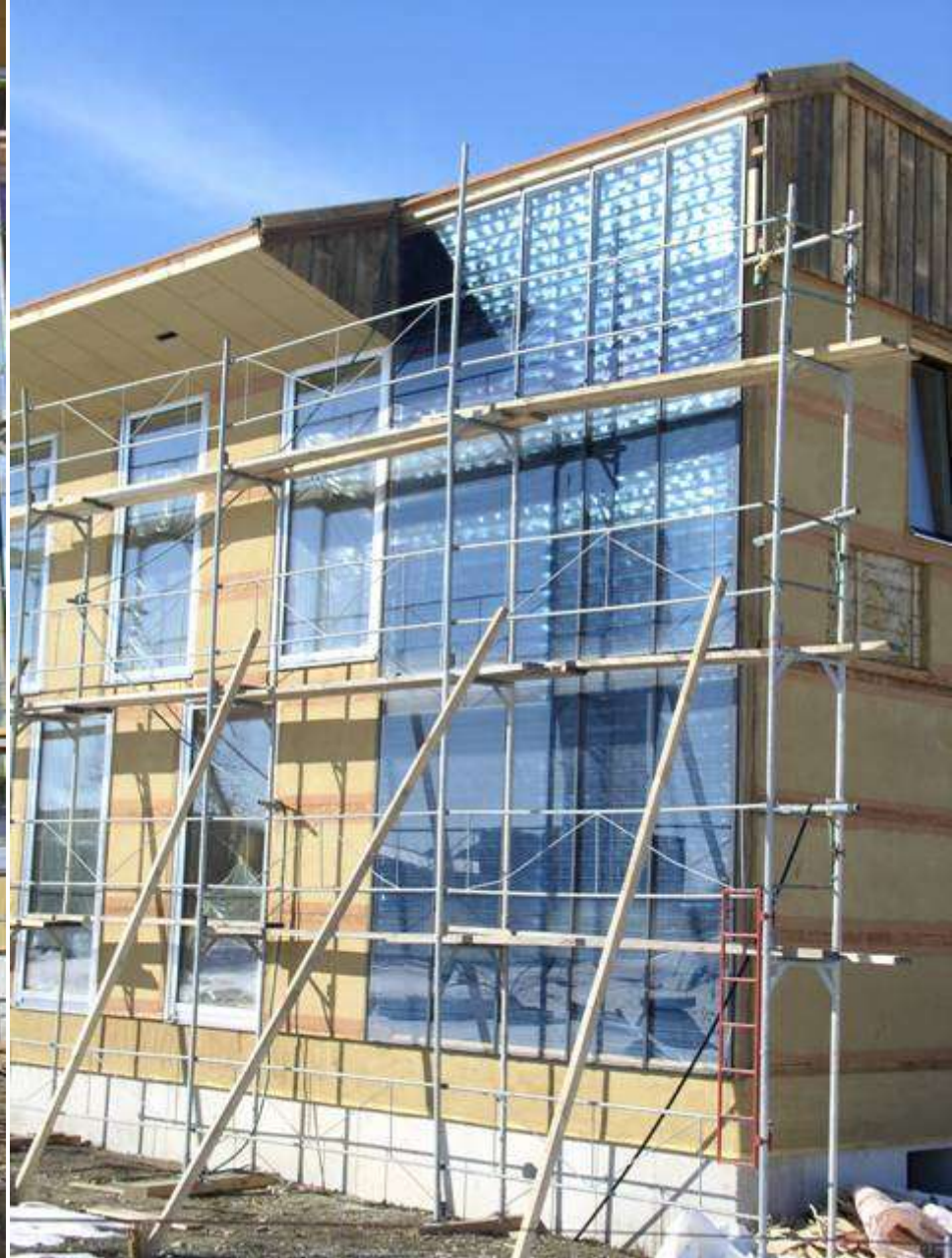
Links: Im Erdgeschoß ein Fassadenfeld mit semitransparenter Schilf-Lehm Wärmedämmung Rechts: Der thermische Solarkollektor
