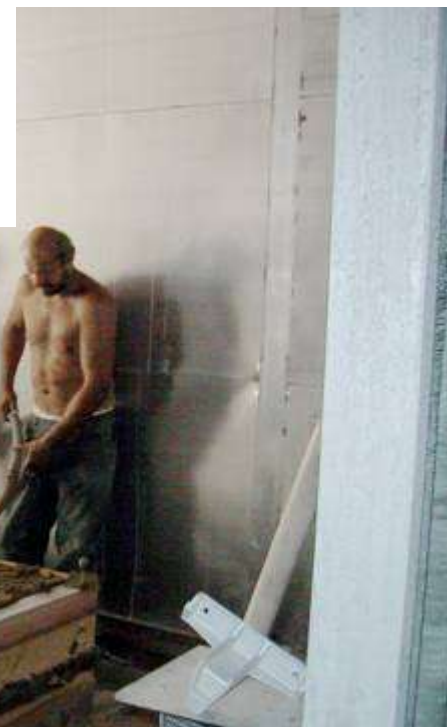
Bild G: Zweilagige Beschichtung der Wandmodule mit Biofaserlehm BFND3 und D2 A. Mikrobletelle statt chemischer Stabilisierung ermöglicht den Einsatz von Lehmbaustoff auch an bewitterten Außenwänden. Im Hintergrund ein bereits fertig beschichtetes Außenwand-Modul.
