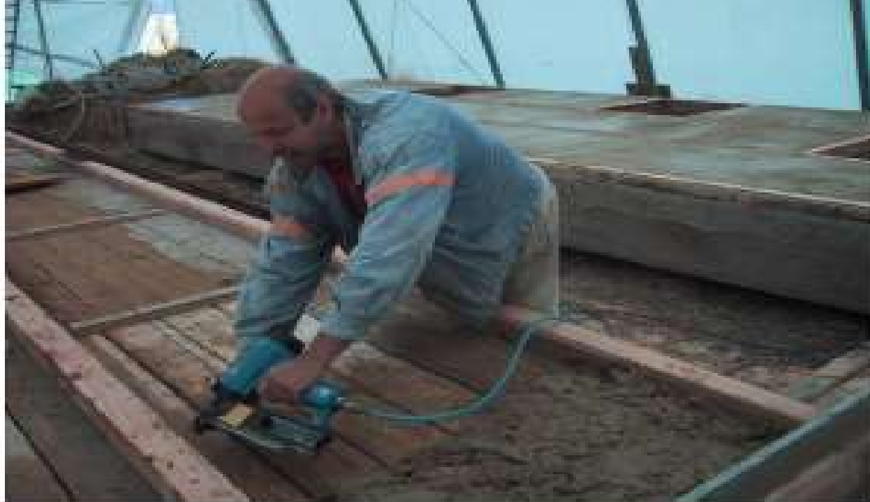
Bild G: Zweilagige Beschichtung der Wandmodule mit Biofaserlehm BFND3 und D2 A. Mikrobletelle statt chemischer Stabilisierung ermöglicht den Einsatz von Lehmbaustoff auch an bewitterten Außenwänden. Im Hintergrund ein bereits fertig beschichtetes Außenwand-Modul.
