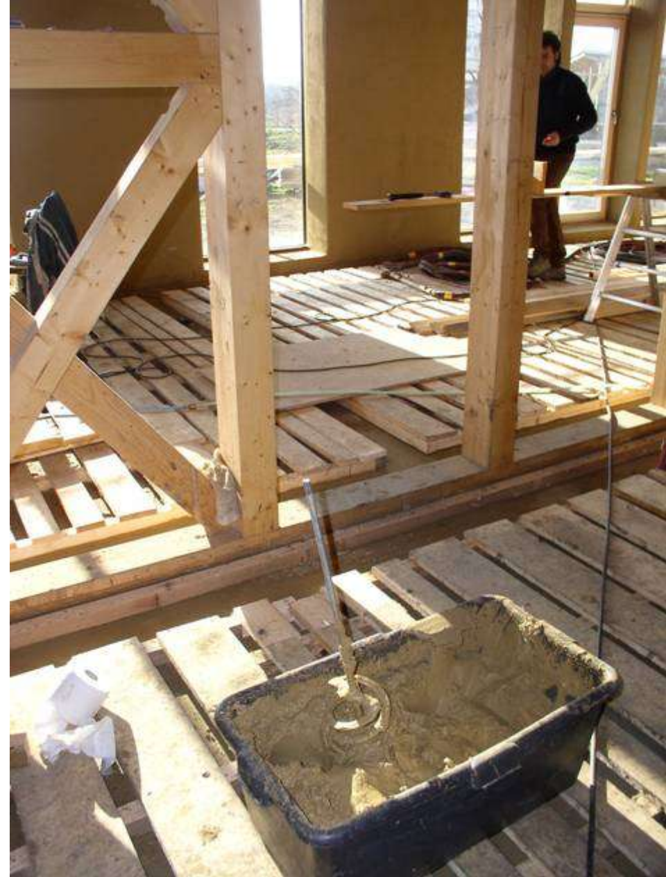
Ganz links: Im Werk vorgefertigte Ausfachung zweier Mittelwand-Felder mit Stampflehm Im Vordergrund: Biofaser-Lehm-Fertigplatten zur rationellen Montage in den ausgekreuzten Gefachen
